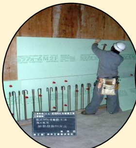
断熱材・インサート先付け
