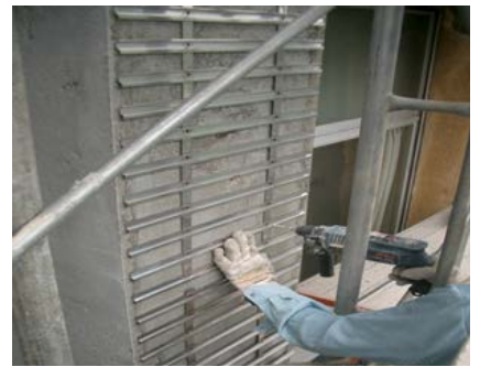
■Ⅲ型金物取付け
