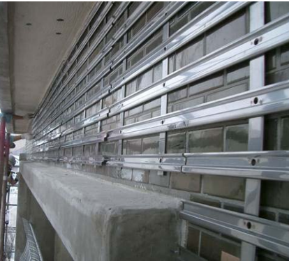
■ 既存壁にⅢ型レール取付け
