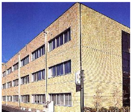
■吹付けから二丁掛、後目地仕上げ
