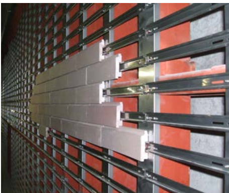
■地下鉄の振動を考慮し鉄骨下地へ
