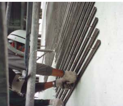
■ I型レールの取付け
