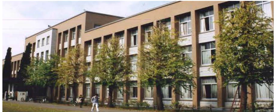
■完成 3000㎡改修・既存壁の浮きもEPアンカー16本/㎡と金物で押え込み
