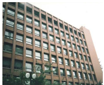
■ 完成 8000㎡の補修完了
