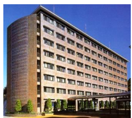
■新築校舎二丁掛、後目地仕上げ
