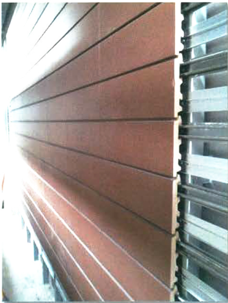
陶板嵌め込み状況 (外断熱陶板施工例)
