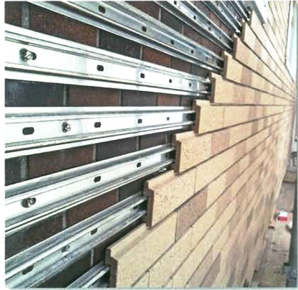
タイル嵌め込み状況 (タイル ON タイル改修例)
