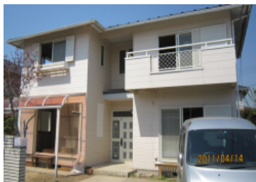
■千葉/改修サテイングに断熱材20mm後張り
