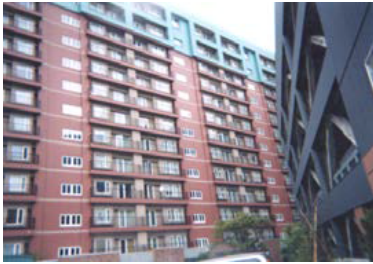
■小樽/断熱材75mm型枠先付け
