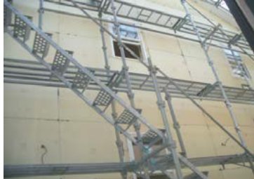
■東京/外壁タイルリニューアル・断熱材後張り
