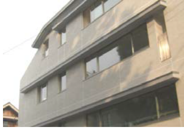
■東京/断熱材35mm型枠先付け・タイル・ス留併用
