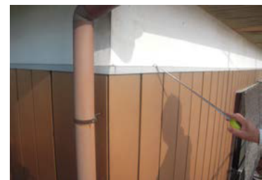
■埼玉/改修金属サテイングに断熱材20mm後張り
