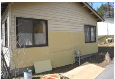
■長野/改修木仕上げに断熱材35mm後張り
