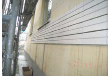
■東京/断熱材35mm型枠先付け・タイル・ス留併用
