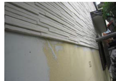
■埼玉/改修金属サテイングに断熱材20mm後張り
