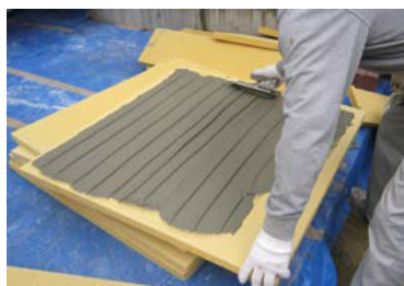
■千葉/新築外断熱35mm下地にタイル施工
