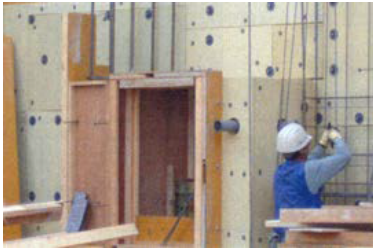
■小樽/断熱材75mm型枠先付け
