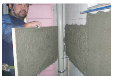
■流山/改修工事モルタル塗装に断熱材20mm後張り
