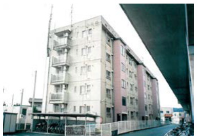
■流山/改修工事モルタル塗装に断熱材20mm後張り
