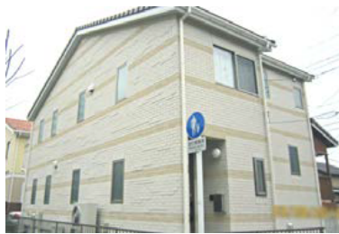
■つくば/改修 断熱材後張り・弾性接着剤タイル施工
