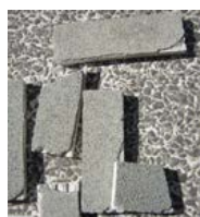
モルタルの接着状況
