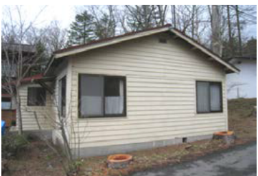
■長野/改修木仕上げに断熱材35mm後張り
