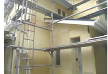
■長野/外壁リニューアル・断熱材後張り
