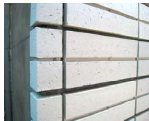
タイルのビス留施工
