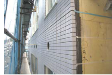
■町田市/断熱材後張り R 壁面
