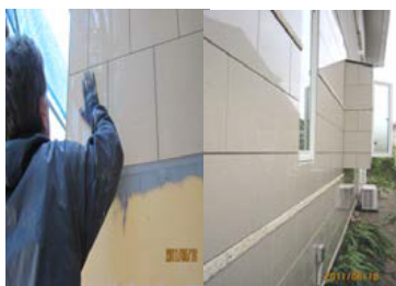
■千葉/改修サテイングに断熱材20mm後張り
