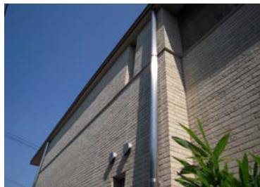
■千葉/新築外断熱35mm下地にタイル施工
