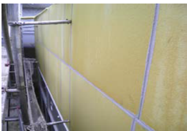
■千葉/新築外断熱下地にタイル施工
