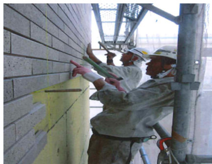
⑥ タイル張り(目地調整)
