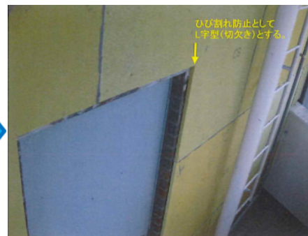
③ 開口部へのボード張り
