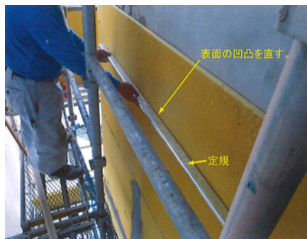
② エアードットボード張り
