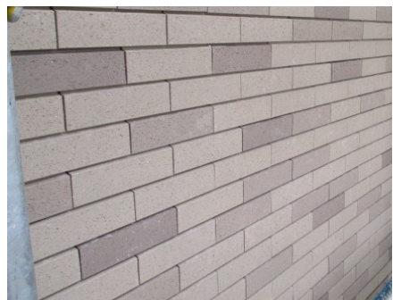
⑦ タイル張り完了
