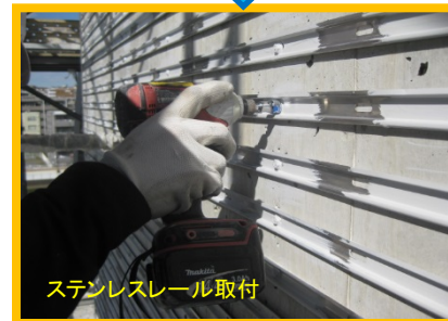
④ コンクリートビス締め
