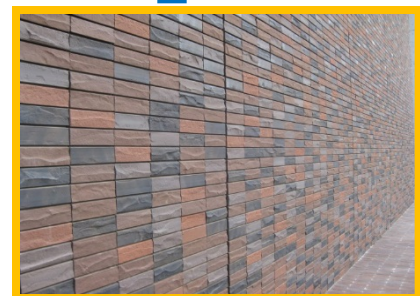
⑧ タイル張り完了
